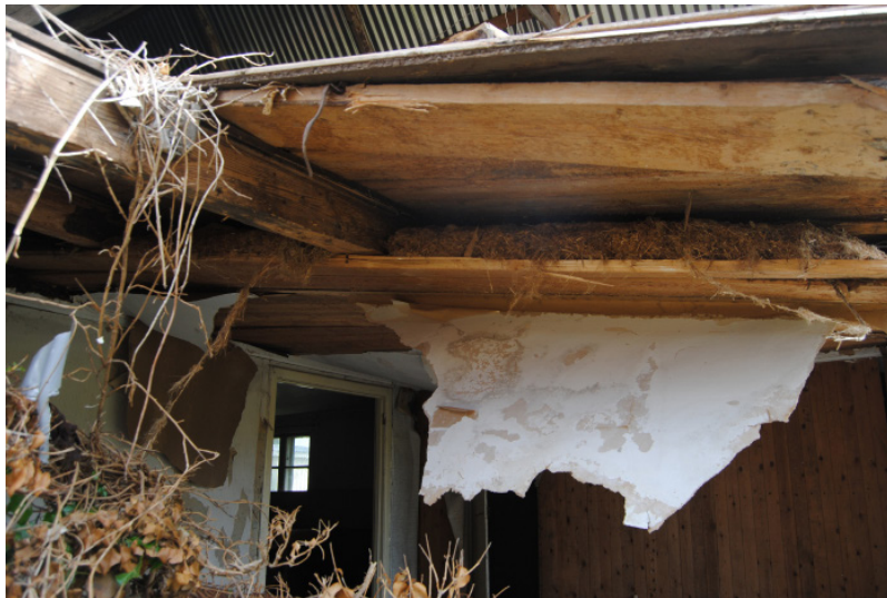
Raserat vindsbjälklag med isolering av tång och sågspån.
